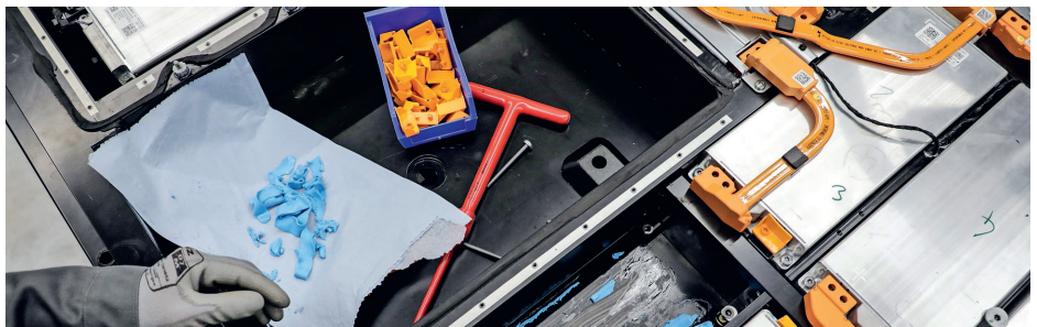
Bevor ein neues Batteriemodul verbaut werden kann, müssen die Reste der Wärmeleitpaste entfernt und eine neue Paste aufgebracht werden. Bei der Dosierung gilt es, nur so viel der teuren Paste wie nötig zu verwenden, aber sicherzustellen, dass der Batterieboden vollständig benetzt wird. Fotos: Porsche
